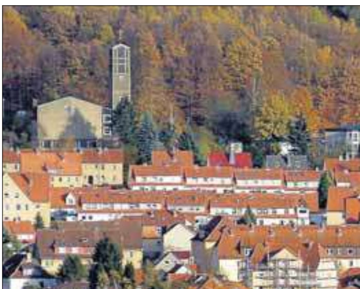
Schwere Bauschäden: Die Kirchengemeinde Hermannshagen kann ihr Gotteshaus nicht mehr nutzen. Archiv-Foto: Schmidt
